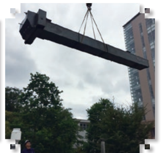
▲ クレーンによる製版カメラの搬出
