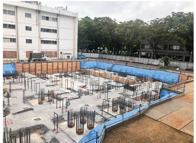
建設中の新講義棟（7号棟2階から弥生通り方面を望む。左奥は6号棟）
